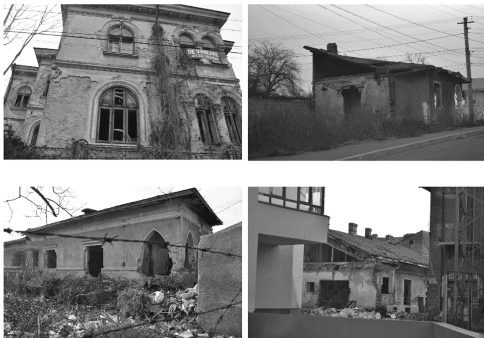
Figura 2-5: Clădiri cu funcție rezidențială, abandonate în municipiul Ploiești
